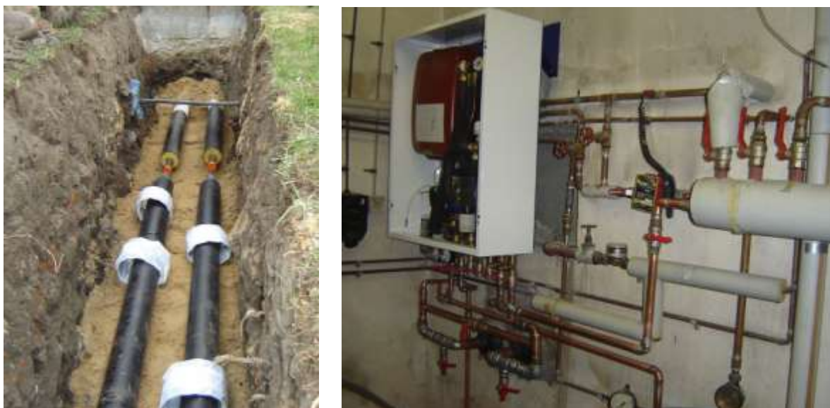
Rys. 4. Sieć ciepłna podziemna (pokazana w czasie budowy) o długości około 40 m i średnicy wewnętrznej 36 mm; węzeł ciepłny c.o. i cwg. o mocy 50 kW, w domu badawczym
