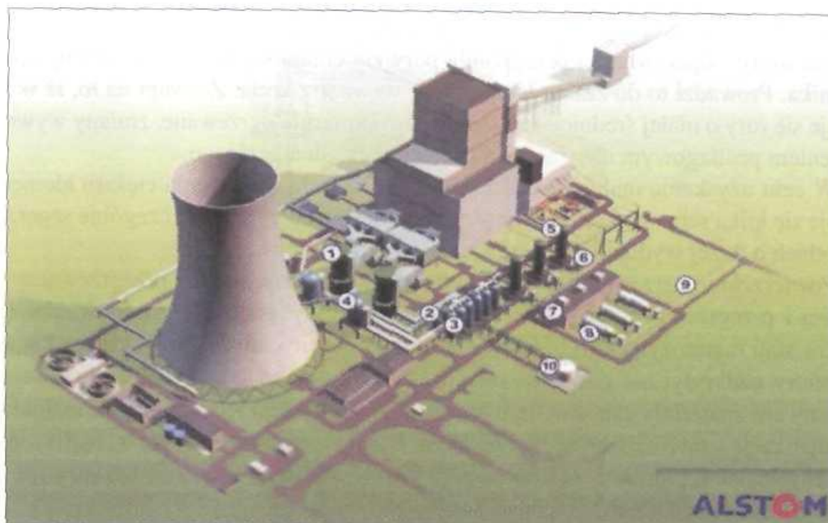
Rys. 3. Koncepcja demonstracyjnej instalacji CCS dla bloku o mocy 858 MW e w Elektrowni Bełchatów II [26]
