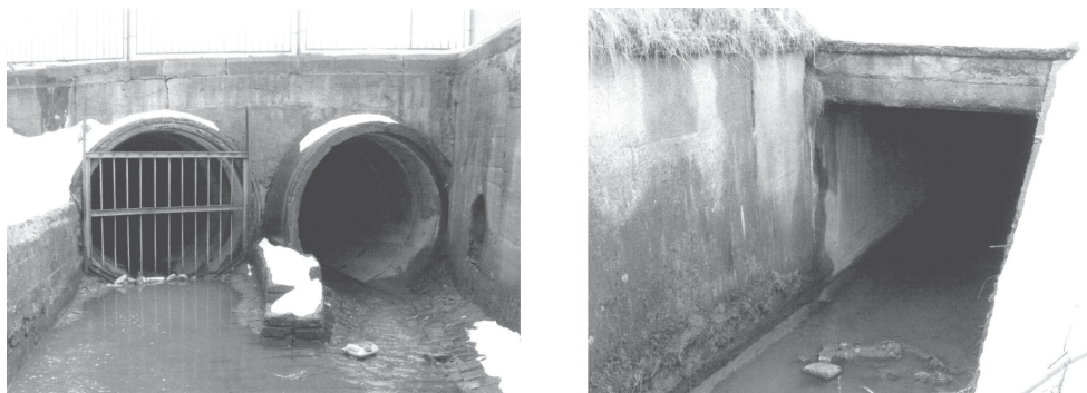
Rys. 2. Wloty do budowli krytego koryta potoku Sobiećinka [2]
